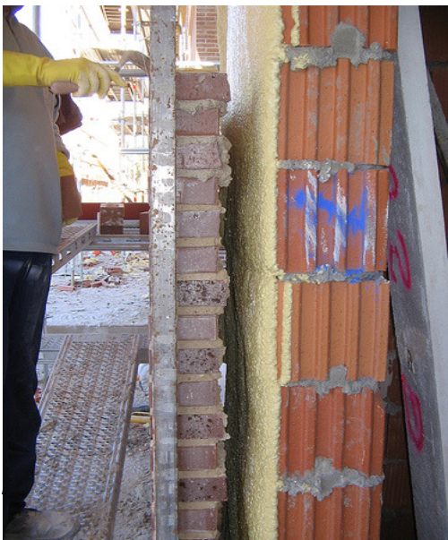
Изоляция монтажной пеной толщиной 3 см:
