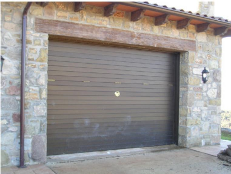
⌘ Секционные подъемные гаражные двери с уравнивающим механизмом и трубчатым оцинкованным каркасом. Состоят из 2-х железных секций размером 2,3х4,35 м шириной – автоматические с дистанционным пультом. Оцинкованные железные двери, обработанные одним слоем антикоррозийного лака и окрашенные в цвет по выбору заказчика.
